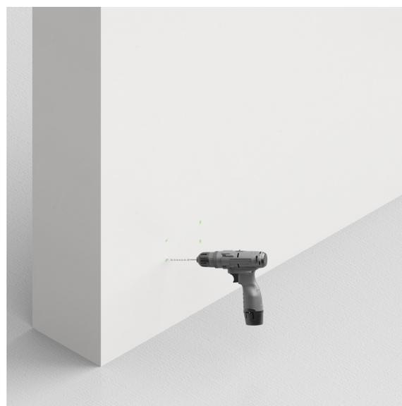
用电钻在标记好的孔位上钻出孔洞。
